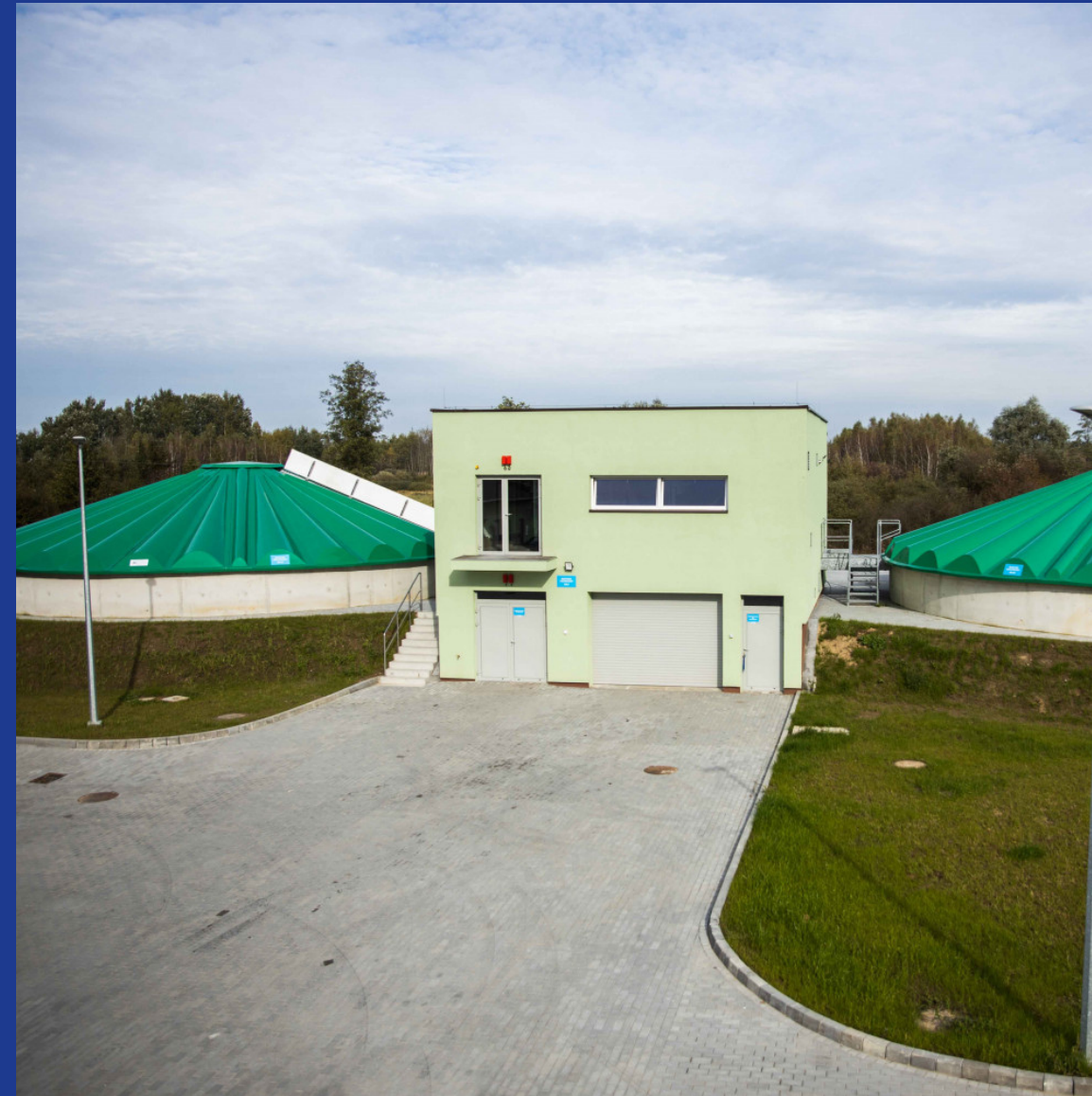
Oczyszczalnia Ścieków Izbiska, Gmina Wadowice Górne
